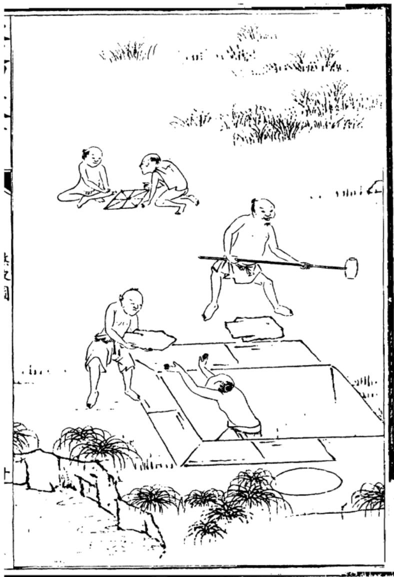
裹築灰淋 灰淋一名灰埴其法於攤場邊近高阜處掘四方土窟一個深二尺許廣五六尺先用牛於濕草地內踏煉筋韌熟泥用鐵鏟掘成四方土塊名曰生田人夫搬擔逐塊排砌淋底築踏平實四圍亦壘築如墻用木槌草索鞭打無縱務要繞圍及底下堅實以防泄漏仍於灰淋側掘一涵井深廣可六尺亦用土塊築壘如灰淋法埋一小竹管於灰淋底下與井相通使流涵入井內
