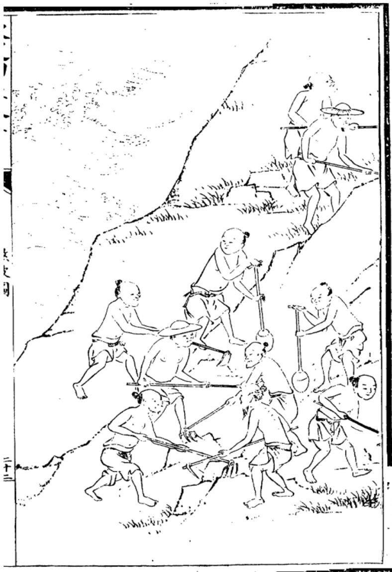
築護海岸 每歲七八月間多起大東北風海潮甚大慮恐湧漲滄沒灰塲時急不能乾有妨攤晒才被滄浸縱晴亦不下六七日不能施功每每多雇人夫高築堤岸以防不測潮汎長落又恐海濤衝激損壞時常巡視有損即補疊以護之
